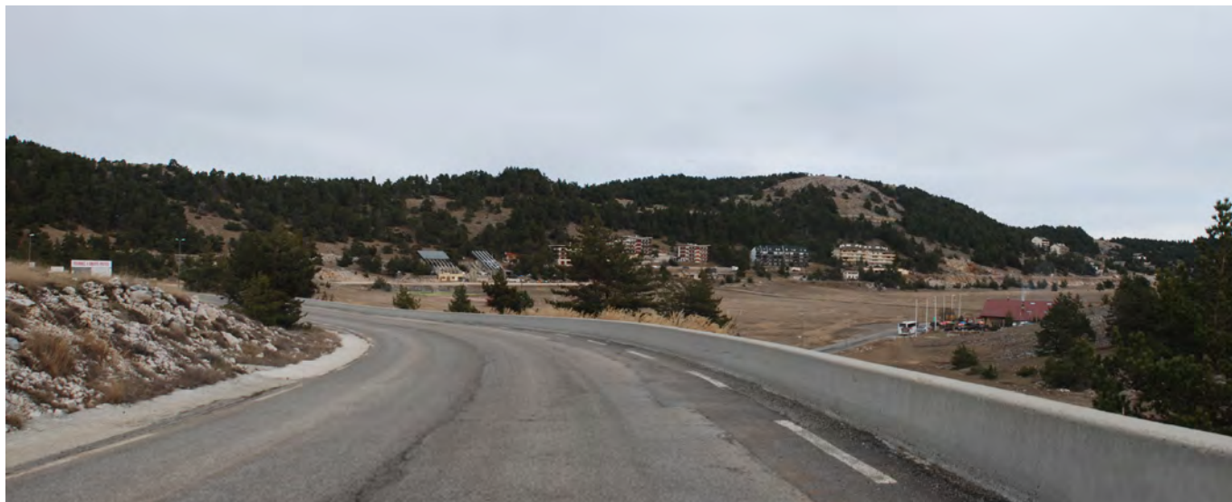
Etat initial (ici l'arrivée sur la station de Gréolières-les-Neiges)
