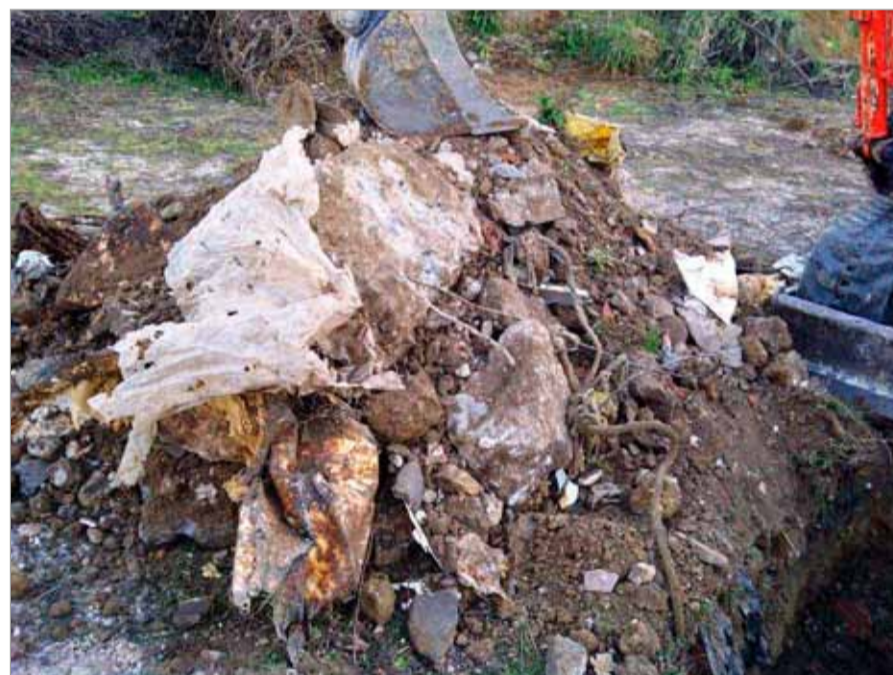
Matériaux excavés du Puits PM3 (source : HYDROGEOTECHNIQUE SUD-EST)
