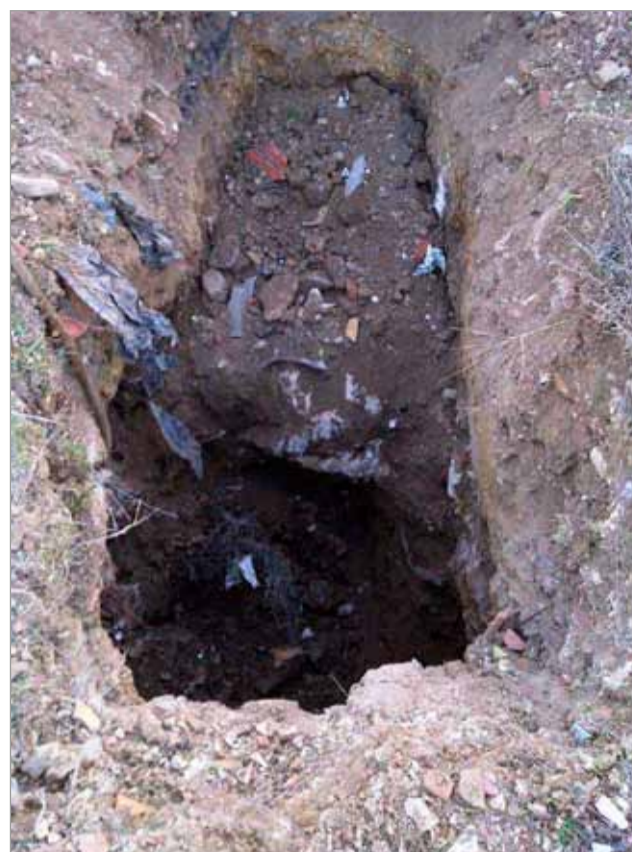
Présence de déchets dans la fouille du Puits PM3 (source : HYDROGEOTECHNIQUE SUD-EST)
