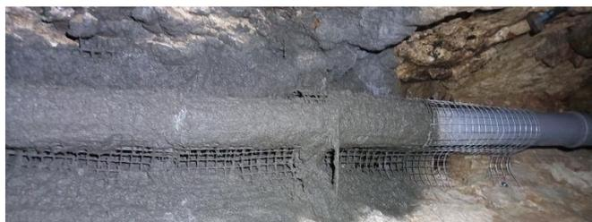
Pose d'un nouveau réseau dans le vallon avec protection armée
