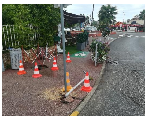
Réhabilitation du collecteur du Bd des Italiens VILLENEUVE LOUBET
